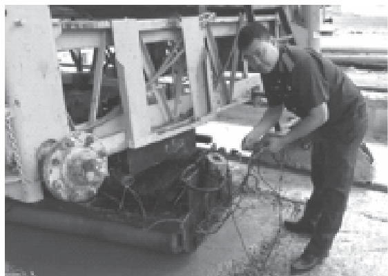
Hình 4. Lắp các thiết bị đo lên cụm trống lăn
