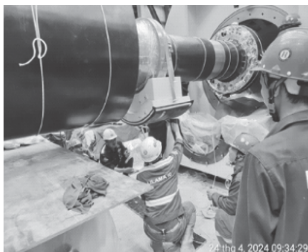
Các kỹ sư và công nhân lành nghề của LILAMA 10 đang kiểm tra lần cuối các điều kiện để lắp Rotor máy phát vào vị trí.
