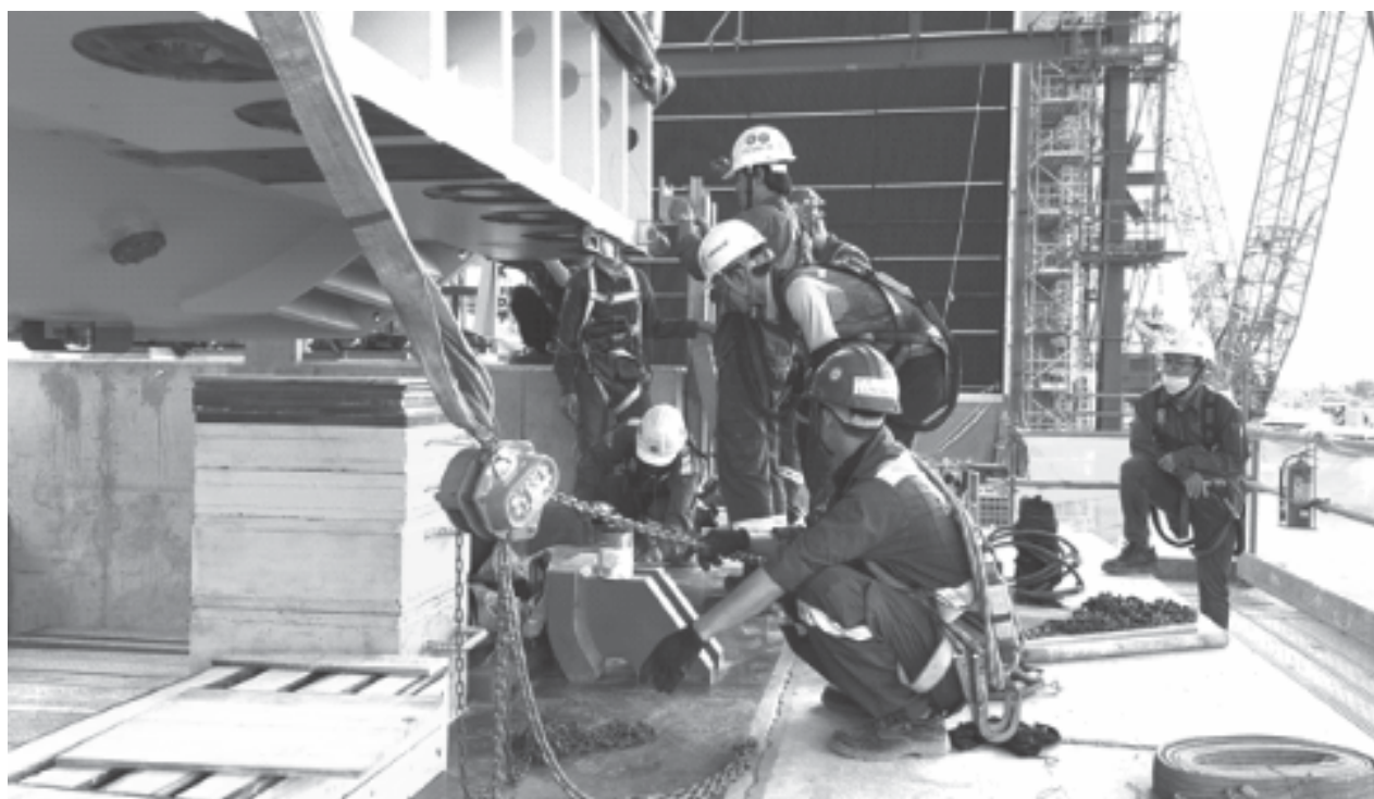
Các kỹ sư, công nhân có trình độ cao và lành nghề của LILAMA 10 đang thi công lắp đặt tại Nhà máy điện Nhơn Trạch 4.
