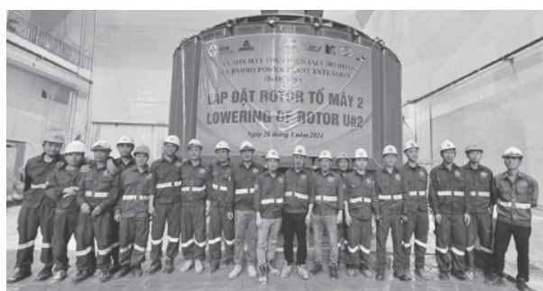
Cán bộ, công nhân viên LILAMA 10 chụp ảnh trước khi bắt đầu lắp đặt Rotor tổ máy số 2.
