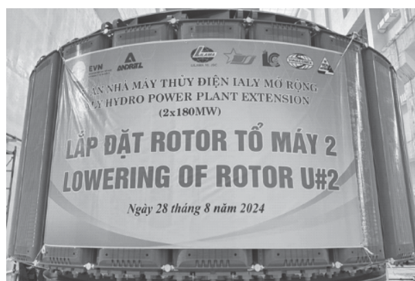
Cận cảnh Rotor tổ máy số 2 được lắp bằng công trục đôi 500 tấn.
