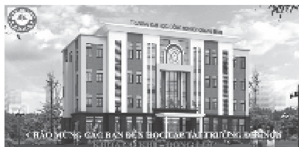
Hình 1. Hình ảnh Dự án Nhà điều hành A2 - Trường ĐHCNQN - QUI đã được khai thác sử dụng 01.2023
