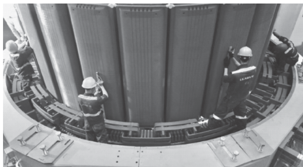
Kỹ sư, công nhân tay nghề cao của LILAMA 10 đang căn chỉnh những công đoạn cuối cho việc lắp đặt Rotor tổ máy số 2 vào Stator.
